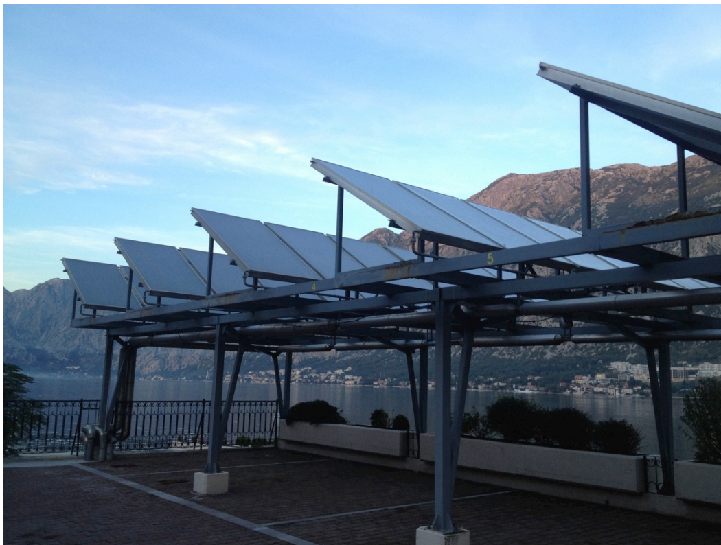
Grafik 8: Solarna instalacija za pripremu potrošne tople vode u hotelu Splendido, Prčanj
