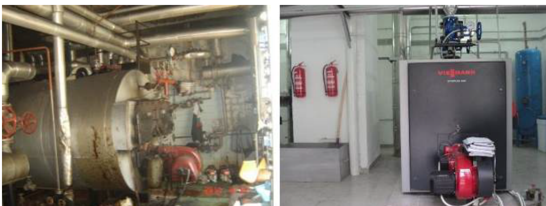
Grafik 3: Kotlarnica specijalne bolnice „Vaso Ćuković“, prije i poslije intervencije
