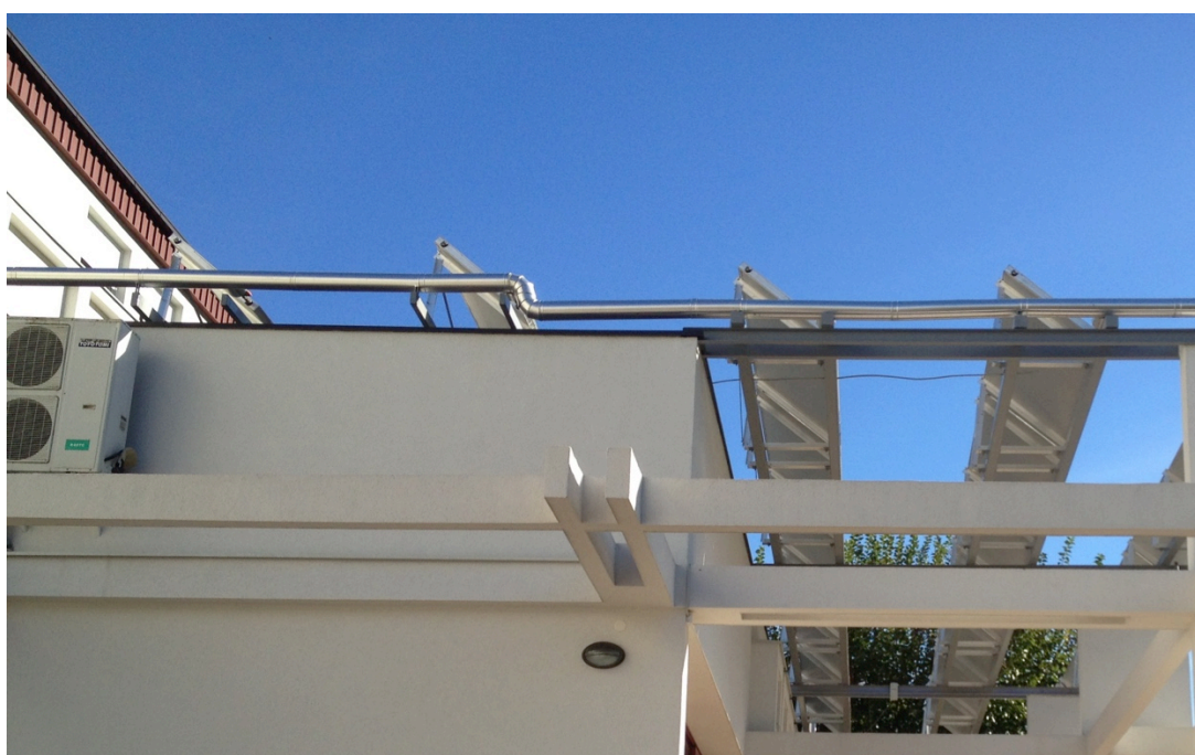
Grafik 11: Integracija Solarne instalacije za pripremu potrošnje tople vode u instalaciji u Studentskom domu "Spasić-Mašera".
