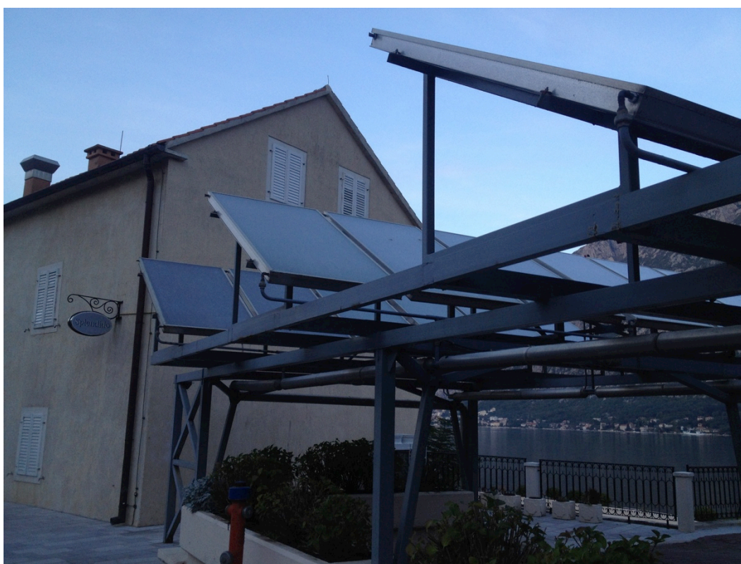
Grafik 9: Solarna instalacija za pripremu potrošne tople vode u hotelu Splendido, Prčanj
