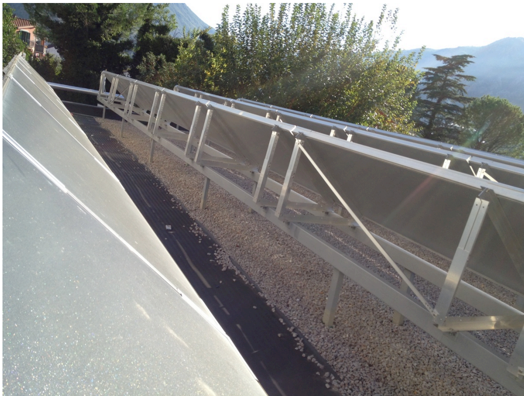
Grafik 10: Detalj solarne instalacije za pripremu potrošne tople vode u instalaciji u Studentskom domu "Spasić-Mašera"
