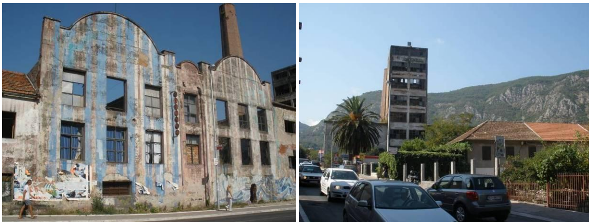
III i IV faza izgradnje fabrike
