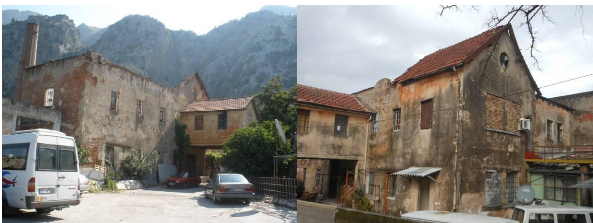
I i II faza izgradnje fabrike
