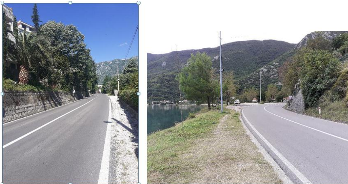
Slika 5. Izgled dijela trase novog TC
