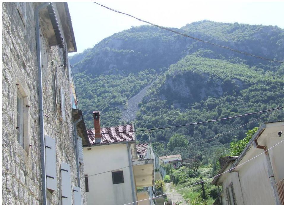
Slika br. 38 – Zona pojačane erozije
