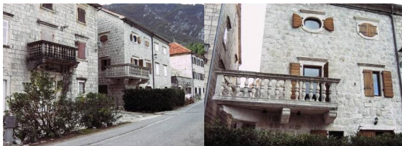
Slika br. 21- kuća Lovrijenca Sbutege
